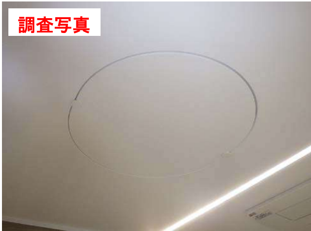
【屋根裏・天井裏】
